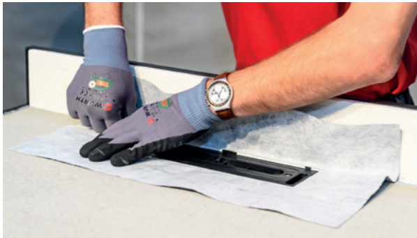
Einbau der Dichtmanschette DallFlex
